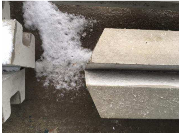
Foto 2 - Úprava koncov prvkov (detail)
